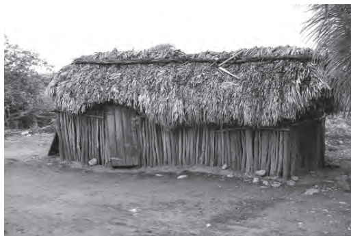
Figura 6 Bohío de palos parados sin embarrado (Prieto)
