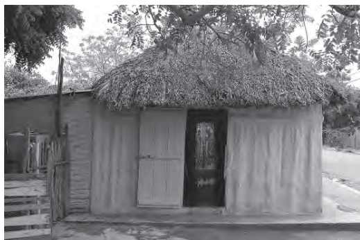
Figura 7 Bohío de palos parados con embarrado (Prieto)
