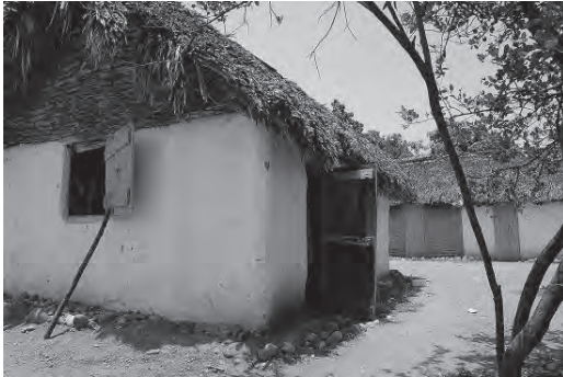
Figura 9 Bohío de bajareque con embarrado (Prieto)
