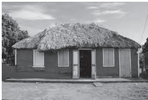
Figura 13 Bohío con techo de cana (Prieto)
