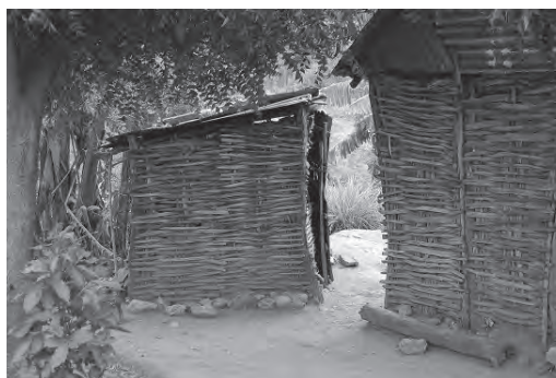
Figura 8 Bohío de bajareque sin embarrado en las paredes (Prieto)
