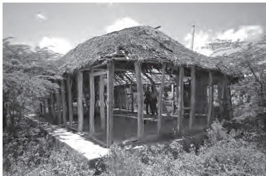
Figura 12 Bohío en el que se puede observar su estructura portante (Prieto)
